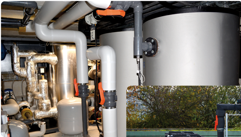
Pufferspeicher (links) bevorraten momentan nicht benötigte Abwärme aus der Produktion, die nachts oder am Wochenende die Luft-Wasser-Wärmepumpe (unten) entlastet.
