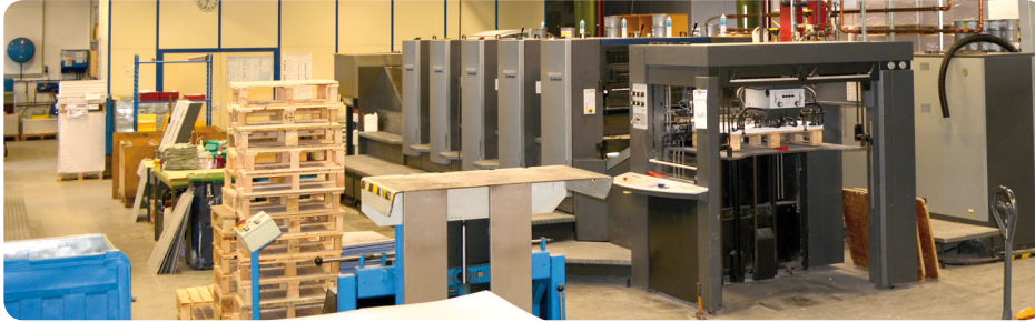
Drucksaal: neue Beleuchtung & Lüftungsanlage
