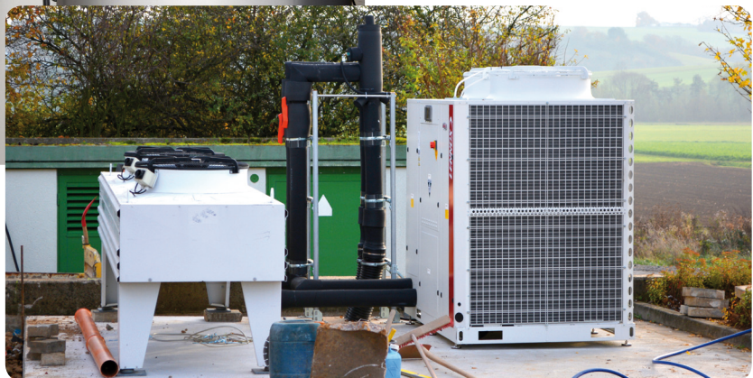
Pufferspeicher (links) bevorraten momentan nicht benötigte Abwärme aus der Produktion, die nachts oder am Wochenende die Luft-Wasser-Wärmepumpe (unten) entlastet.
